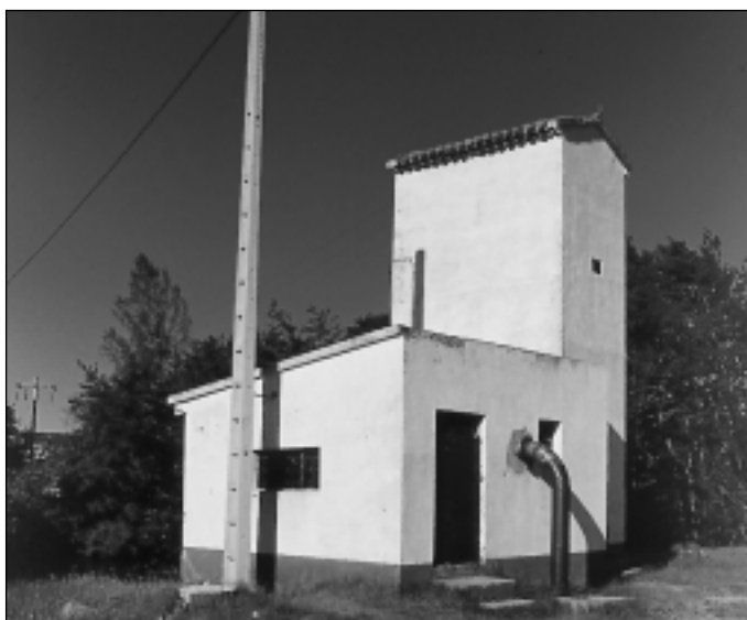
Bombeo para riegos en el Bajo Arlanza. Muchos de estos pozos extraen aguas del propio río a través del acuífero.
