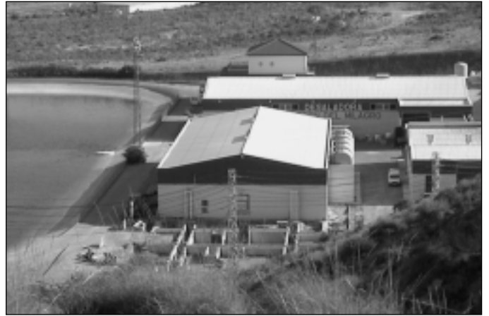
Desaladora Virgen del Milagro, dentro del espacio protegido Sierra de Las Morenas, en Murcia. Esta desaladora aumenta la disponibilidad de agua para regadíos a base de desalar aguas salobres de acuíferos costeros salinizados debidos a una sobreexplotación.
